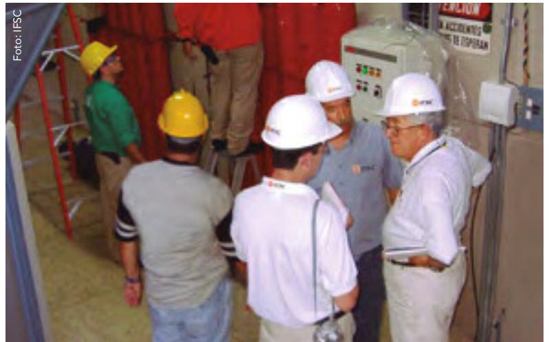
Agentes de Pruebas Integradas planeando las pruebas de los sistemas contra incendios en una central eléctrica (Foto: Cortesía IFSC)
