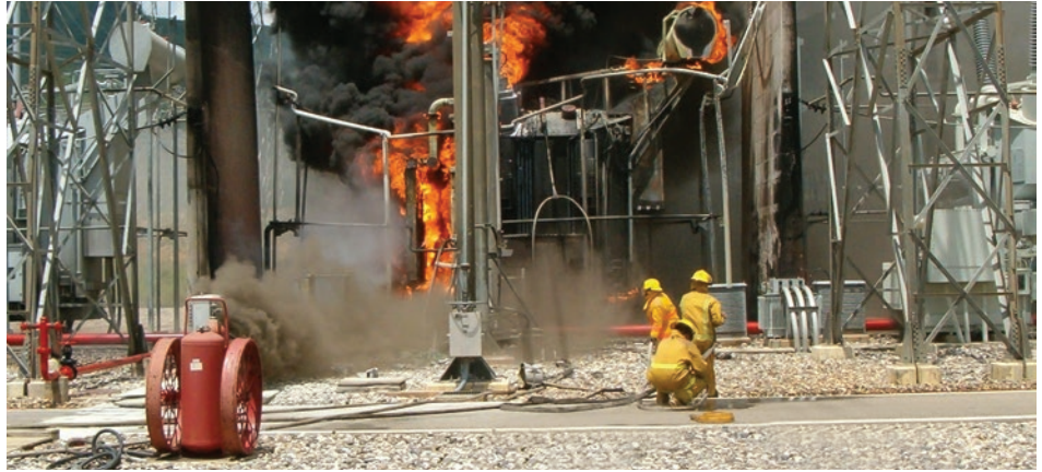
Incendio de un tanque en una playa de tanques de una refinería. Foto: Cortesía iFSC
