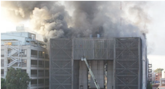
Incendio Centro de Control del Metro de CDMX.
