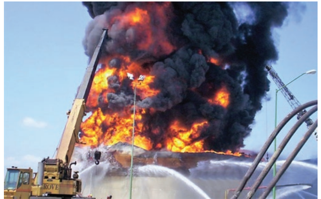
Incendio de un transformador en una subestación eléctrica. Foto: Cortesía iFSC
