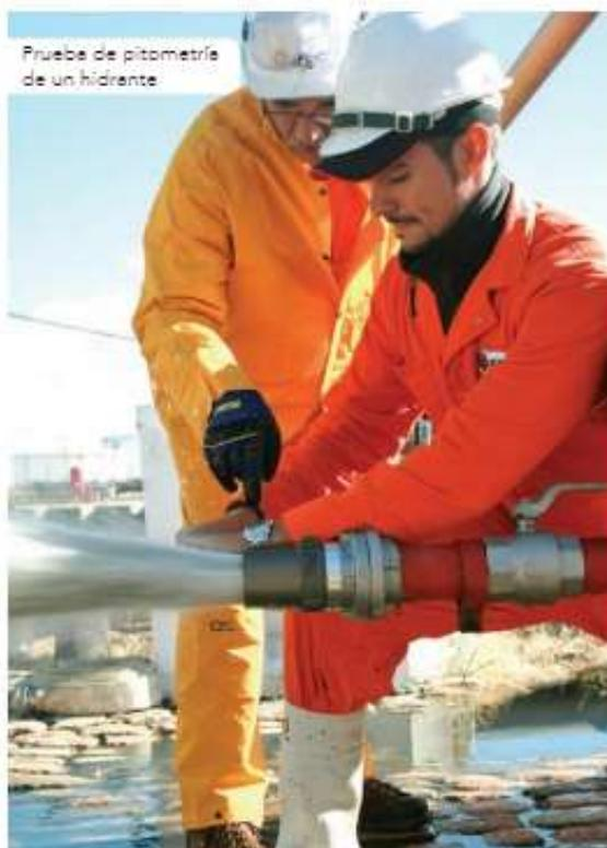
Prueba de pitómetría de un hidrante
