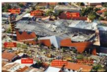
Fotografía aérea después del incendio del Supermercado Ycau Bolaños
