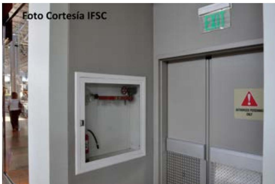
Gabinete de manguera donde, por no ser requerida, se ha retirado la manguera y solo queda la válvula de conexión para la manguera. Foto: cortesía IFSC.
