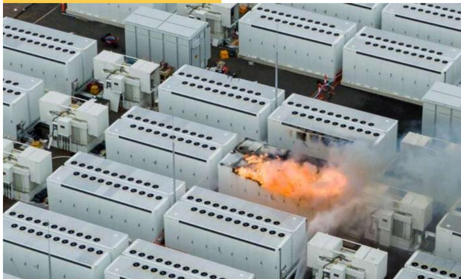
**EN JULIO DE 2021, EN MOORABOOL, AUSTRALIA, OCURRIÓ UN INCENDIO EN UN PARQUE DE BATERÍAS LLAMADO VICTORIAN BIG BATTERY. ESTE PARQUE ESTABA COMPUESTO DE 212 MEGAPACKS, QUE CONJUNTAMENTE TENIAN UNA CAPACIDAD INSTALADA DE 300 MW. LA INVESTIGACIÓN DEL INCENDIO APUNTÓ A UNA FUGA DE REFRIGERANTE LÍQUIDO QUE CAUSÓ ARCOS EN LAS CELDAS DE BATERÍA, ESCAPE TÉRMICO (THERMAL RUNAWAY) Y UNA REACCIÓN EN CADENA. EL INCENDIO DURÓ CUATRO DÍAS**
