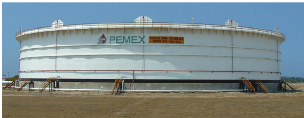
Tanque de techo flotante de 500 mil barriles de crudo protegido con cámaras de espuma
