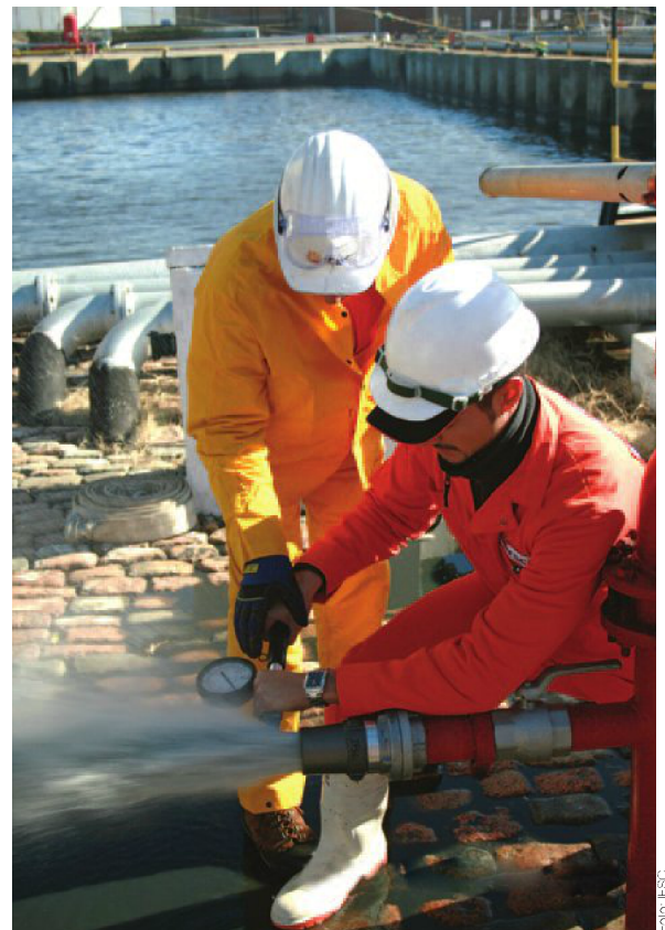
Prueba hidráulica de un hidrante con tubo pitot manual
