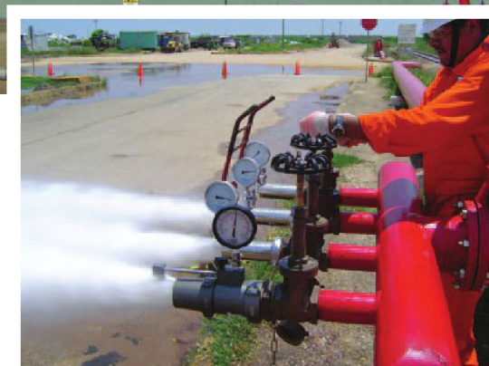
Prueba hidráulica en una red con tubos pitot fijos
