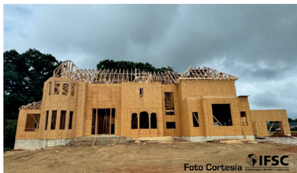
Foto 2 - Residencia en construcción con elementos en madera.
