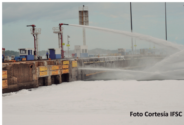
Fotos 4 - 5: Pruebas operativas del sistema de extinción por espuma protegiendo las esclusas del Canal de Panamá.
