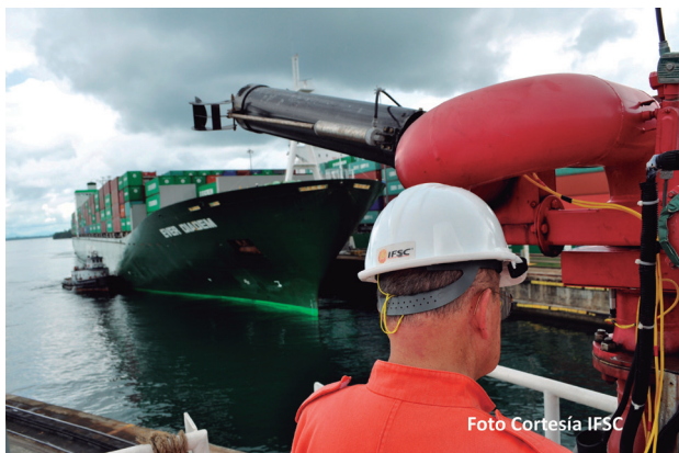
Fotos 4 - 5: Pruebas operativas del sistema de extinción por espuma protegiendo las esclusas del Canal de Panamá.
