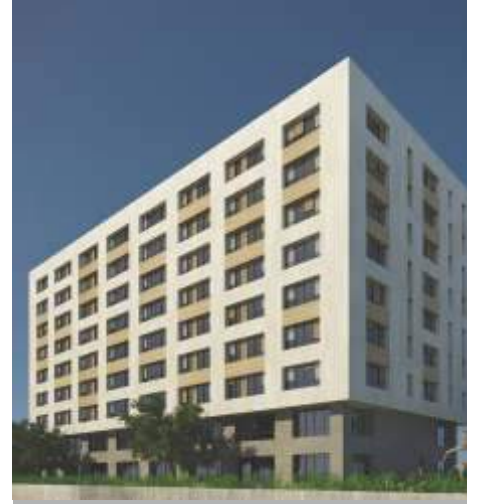
SOYAK İNŞAAT SOHO PROJESİ - İSTANBUL
