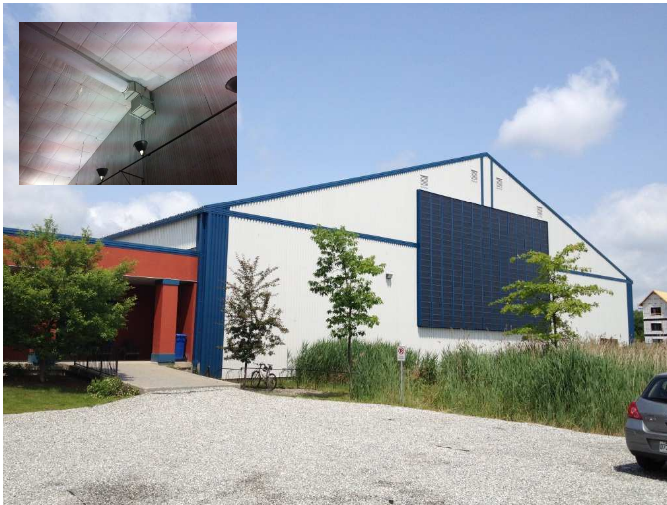
Club de tennis et centre sportif Tennis club and sports center – 100 m 2
