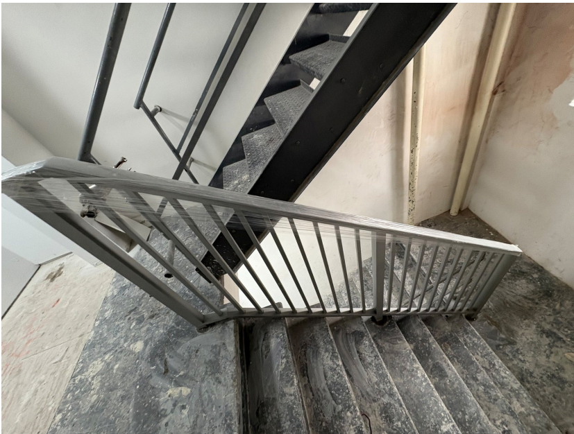
Baranda interior de escalera
