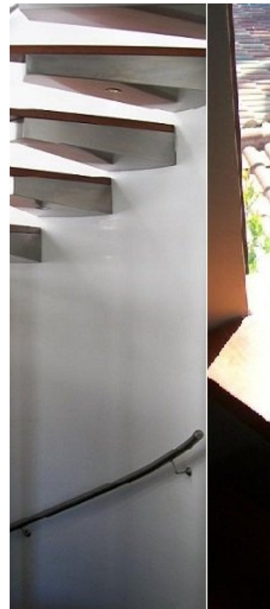
Escalera curva arquitectónica
