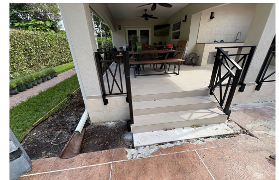
Baranda de entrada
