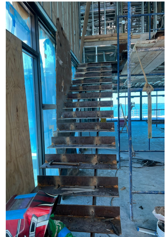
Instalación de escalera en obra
