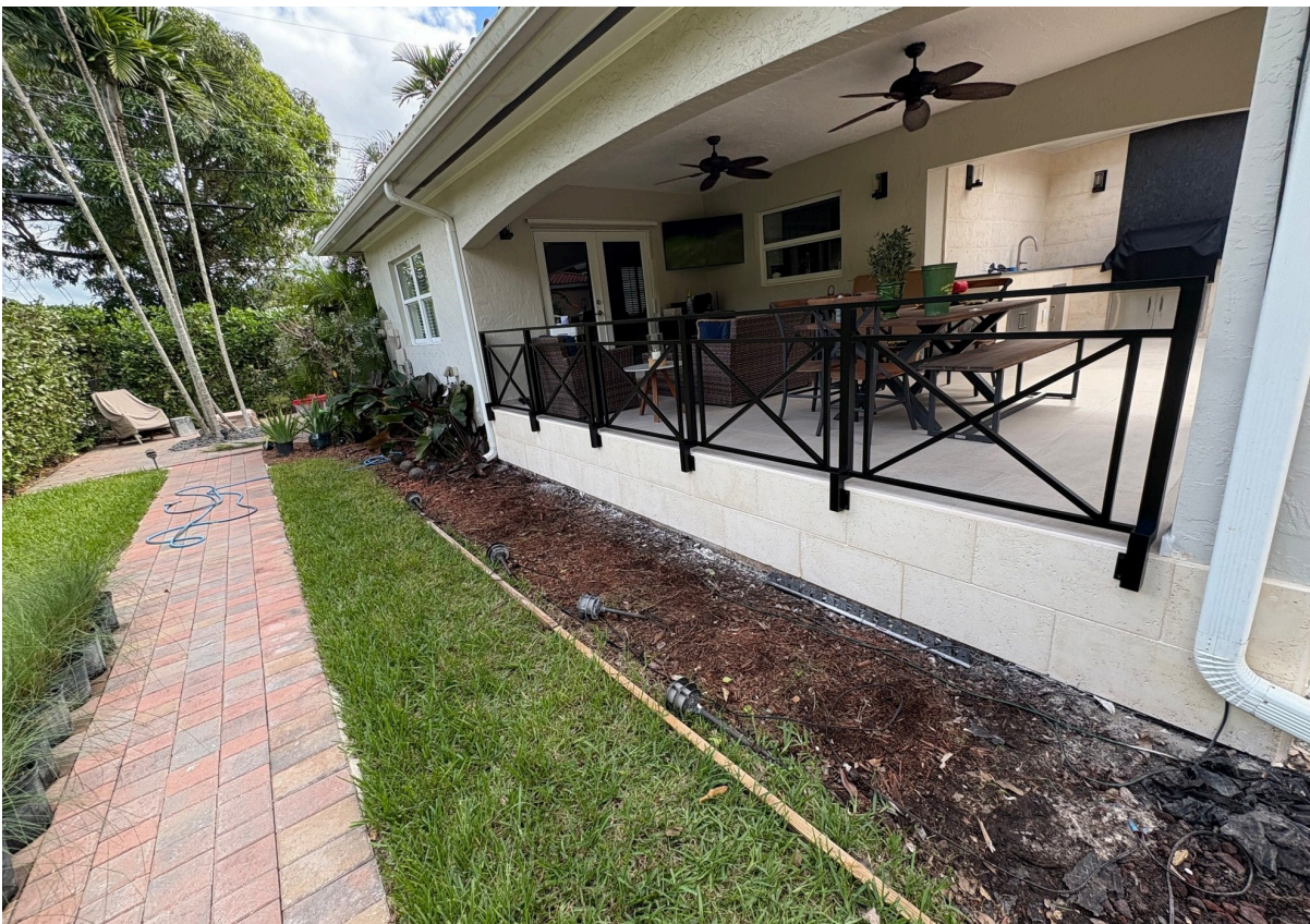
Vista de baranda de patio
