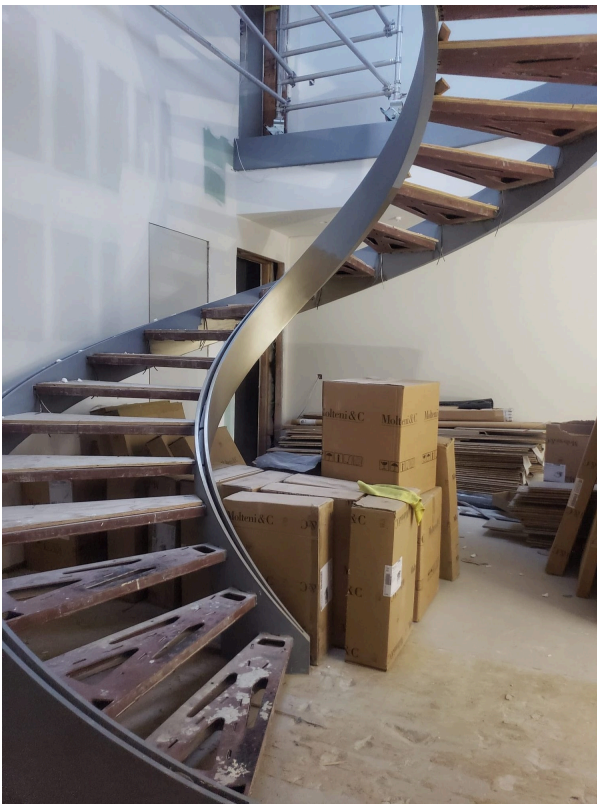
Instalación de escalera curva
