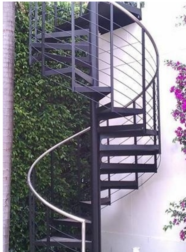
Escalera espiral con baranda a medida
