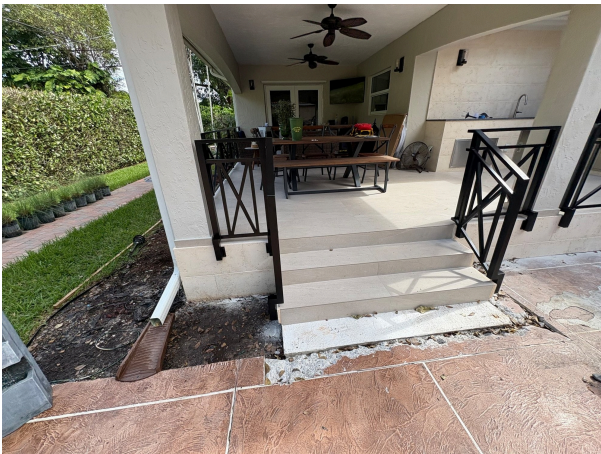
Baranda de escalera
