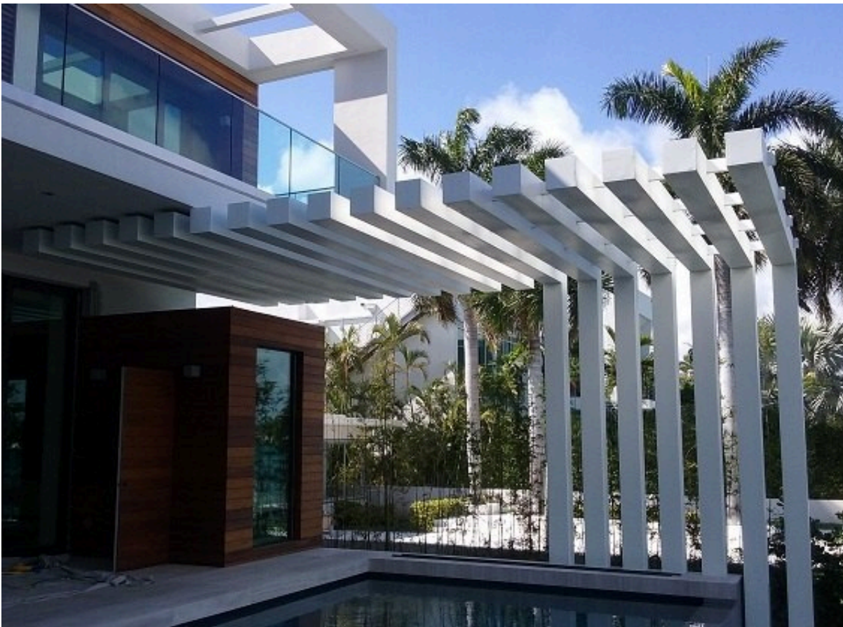
Pérgola de aluminio / estructura exterior
