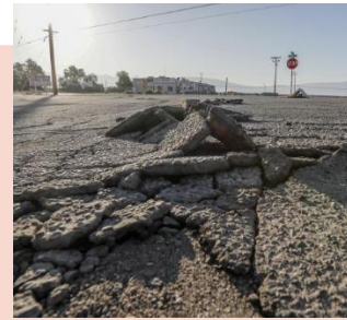
Detección de huecos y fracturas bajo el pavimento
