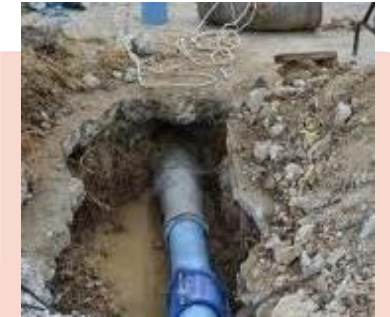
Detección de tuberías
