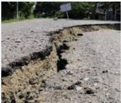
Mapeo de fallas, fracturas, cavidades y cambios laterales de materiales.
