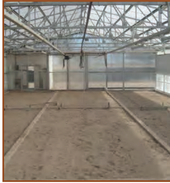
Figura 11. Canaletas de cemento
