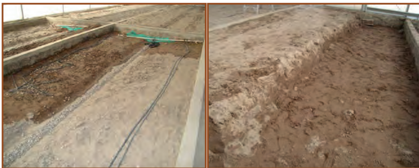
Figura 13. Canaletas llenas de arena de río, con sistema de drenaje
