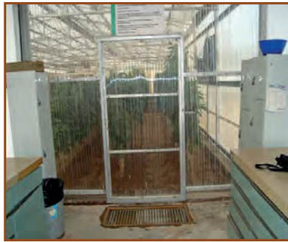
Figura 40. Fosa de desinfección a la entrada del invernadero
