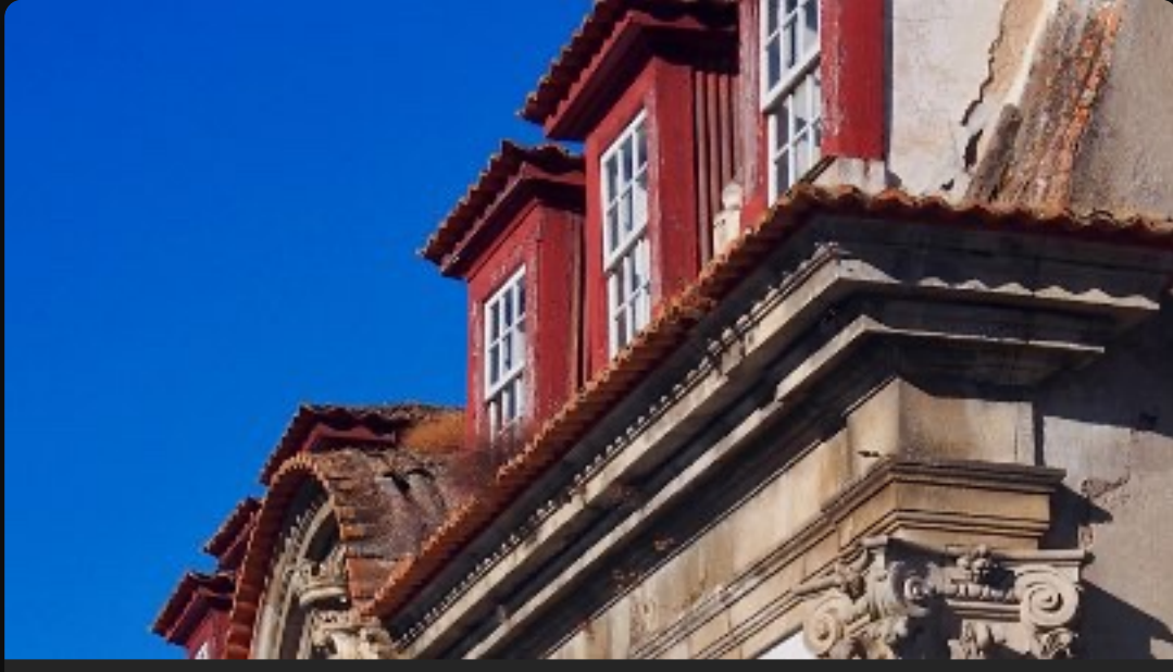
Front of Morgadio de Calçadas in Provesende
