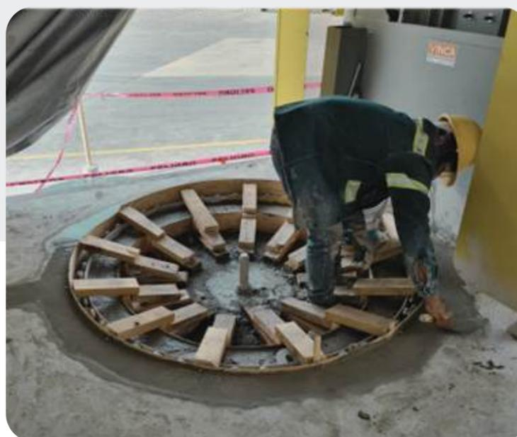
*Elaboración de platillo giratorio, para extracción y manejo de residuos*
