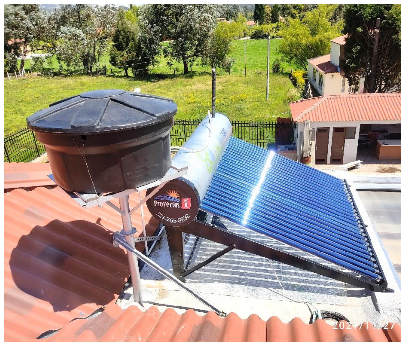
Suministro e instalación profesional tanque de reserva con estructura elevada; desfogue, salida para lavado, derivaciones para ampliación futura y llegada a los puntos de servicio
