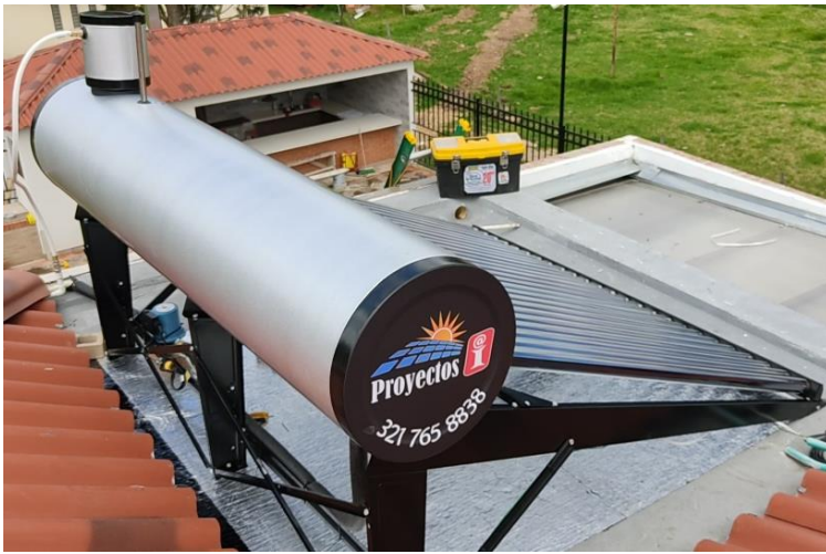
Calentador a gravedad 290 L con bomba presurizadora
