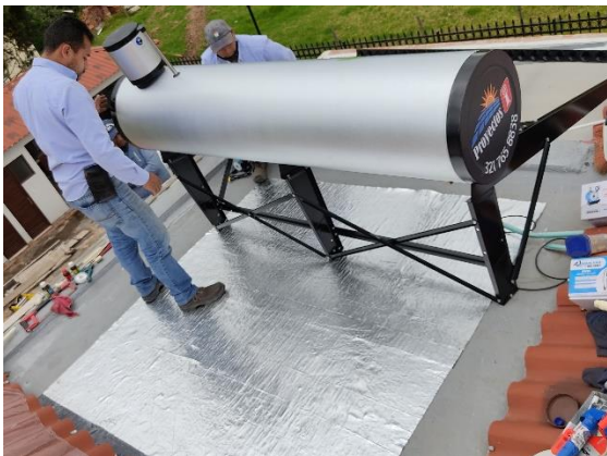
Instalación reflector de aluminio en el piso
