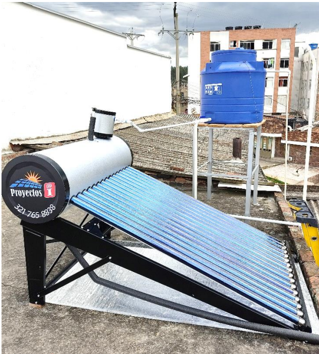
Suministro e instalación profesional tanque de reserva con estructura elevada; desfogue, salida para lavado, derivaciones para ampliación futura y llegada a los puntos de servicio
