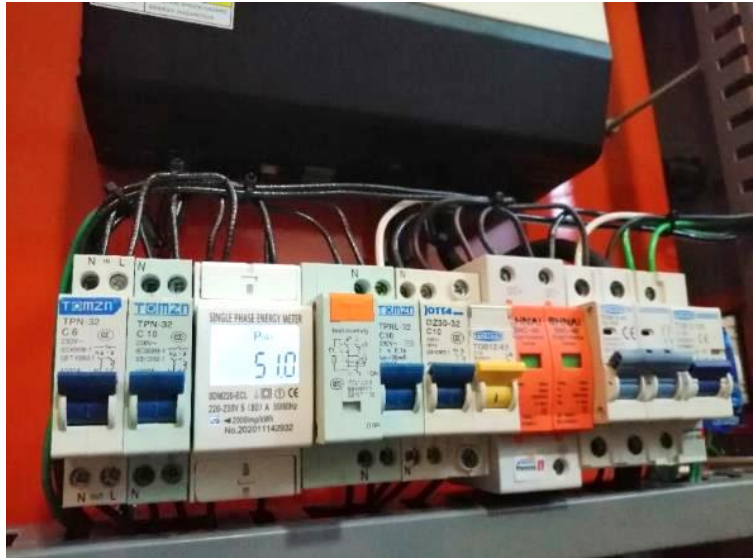
Todos los elementos de protección y circuitos ya cableados
