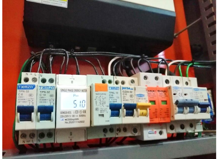
Todos los elementos de protección en cumplimiento del RETIE
