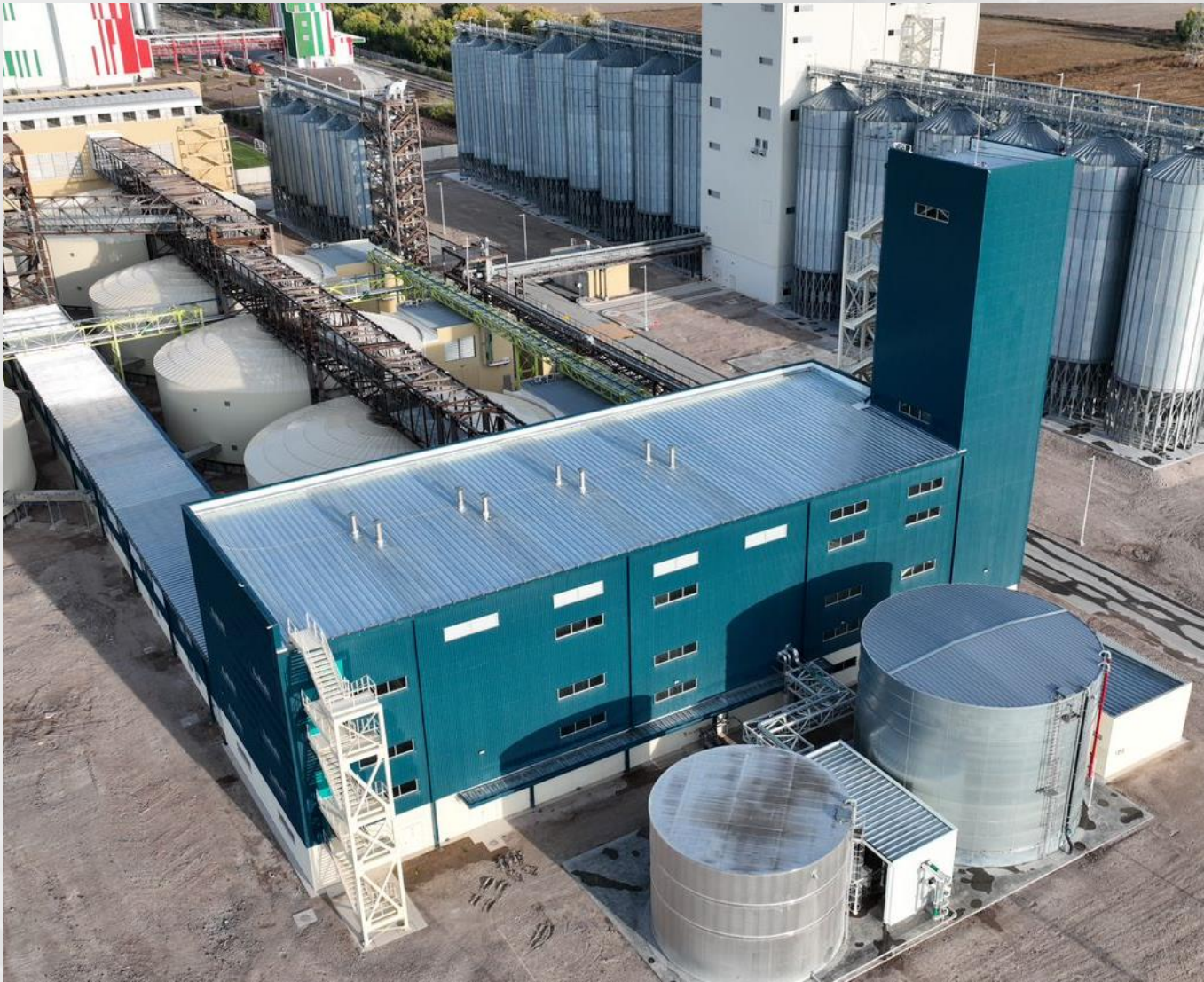
Estructura metálica y lámina
