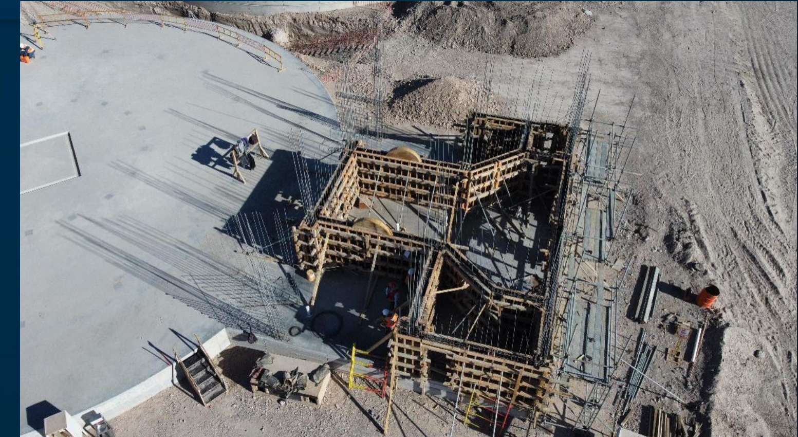
Muros de concreto
