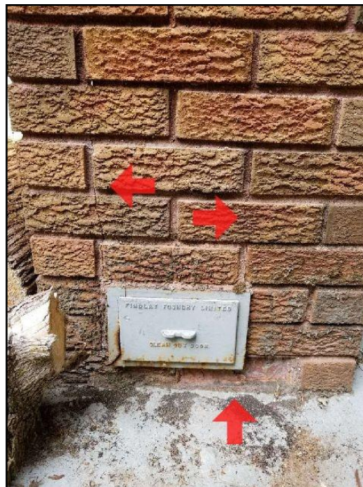
102. Spalling
