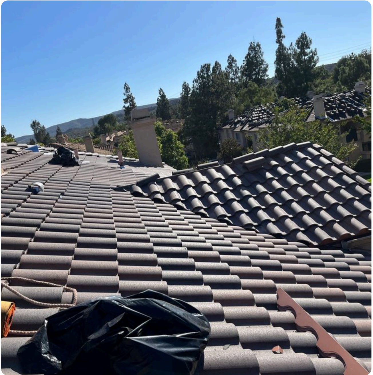
Bldg. #4 (18-32 Fulmar Lane)
