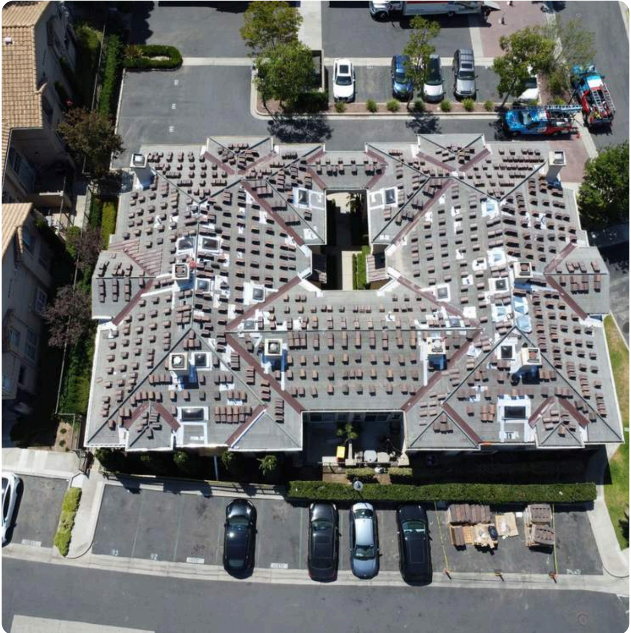
Bldg. #4 (18-32 Fulmar Lane)
