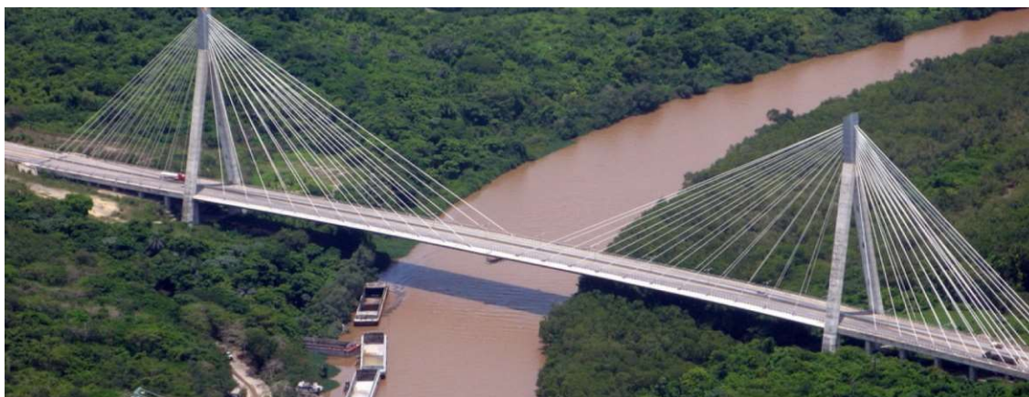
Foto 1. Vista de la cobertura de manglares en ambas márgenes del Río Higuamo en San Pedro.
