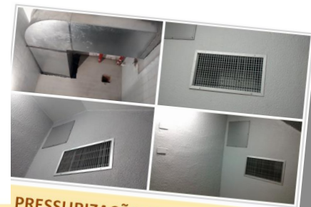
PRESSURIZAÇÃO ESCADA INTERNA Dutos / grelhas / pintura
