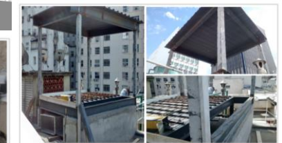
CASA DE MÁQUINA EXATÇÃO NA COBERTURA
