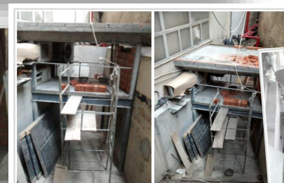
CASA MÁQUINA PRESSURIZAÇÃO DA ESCADA INTERNA
