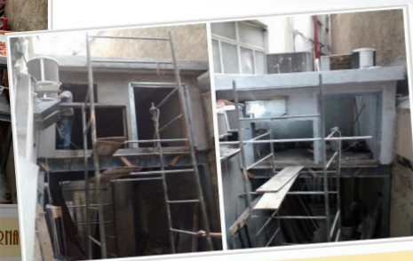
CASA MÁQUINA PRESSURIZAÇÃO DA ESCADA INTERNA
