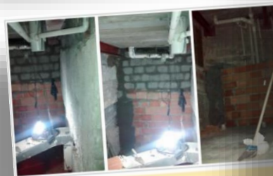
ESTRUTURA METÁLICA LAJES PRUMADA DE BANHEIROS NOVOS
