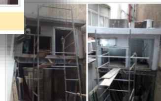
CASA MÁQUINA PRESSURIZAÇÃO DA ESCADA INTERNA
