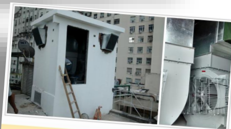
CASA DE MÁQUINA EXAUSTÃO NA COBERTURA
