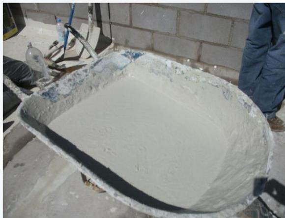
Preparar una Mezcla con 13.5 a 14 lts de agua por cada saco de MasaRoca Impermeabilizante, la mezcla debe ser homogénea teniendo la precaución de no dejar grumos, deje reposar por 3 minutos la mezcla y vuelva a batir antes de aplicar.
