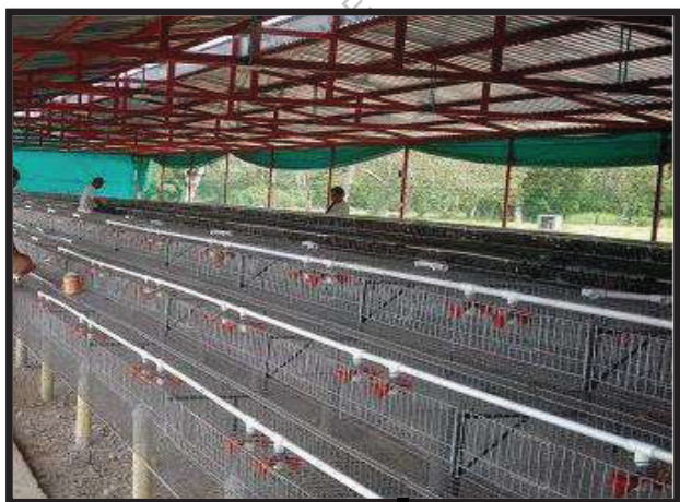
Figura 29. Iluminación del galpón
