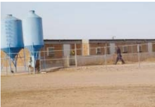
Pasillos de comunicación dentro de la granja
