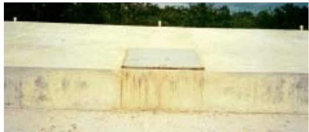
Pits de concreto
