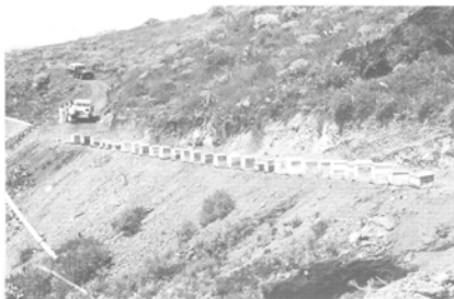
Colmenar provisto de acceso para vehículos.
