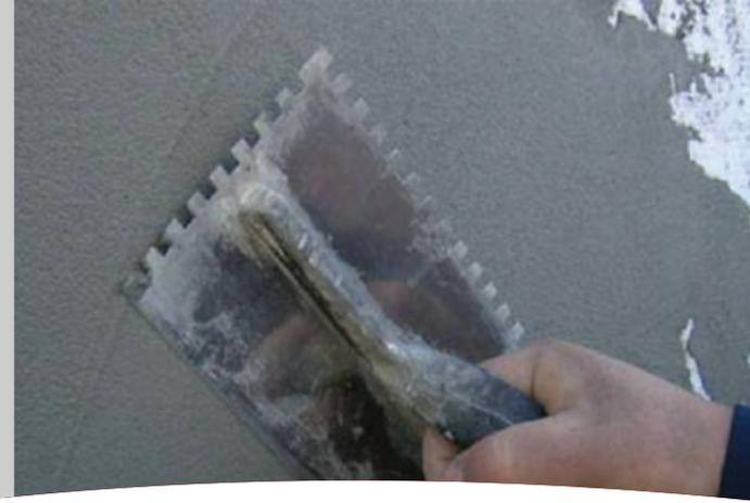
**Mortero cementicio elástico para impermeabilizaciones de estructuras de concreto.**
