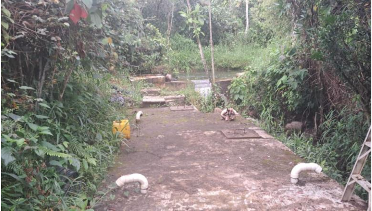
Imagen 4. Tanque de desarenador
