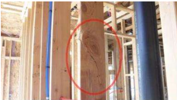
CRACKED WALL STUD.
