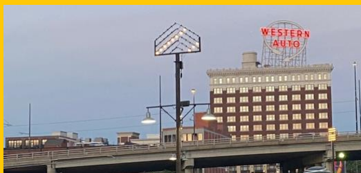
Construindo em torno do Restaurante Jack Stack
