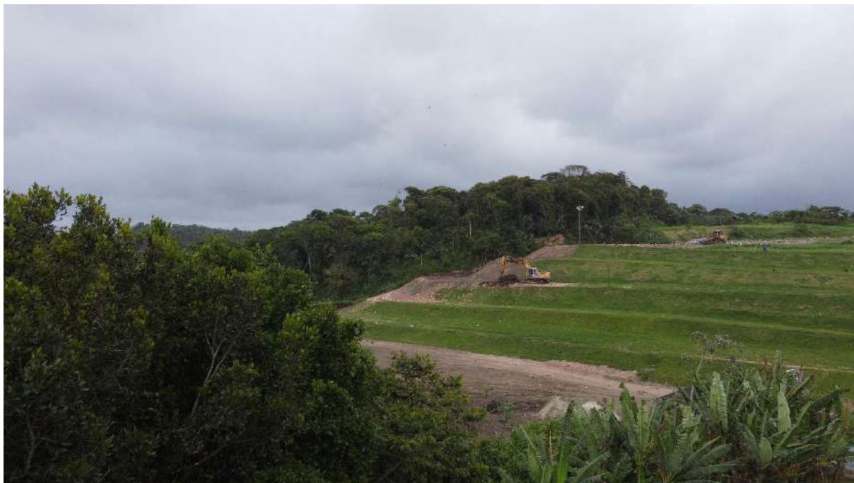
Aterro Sanitário Peruíbe
