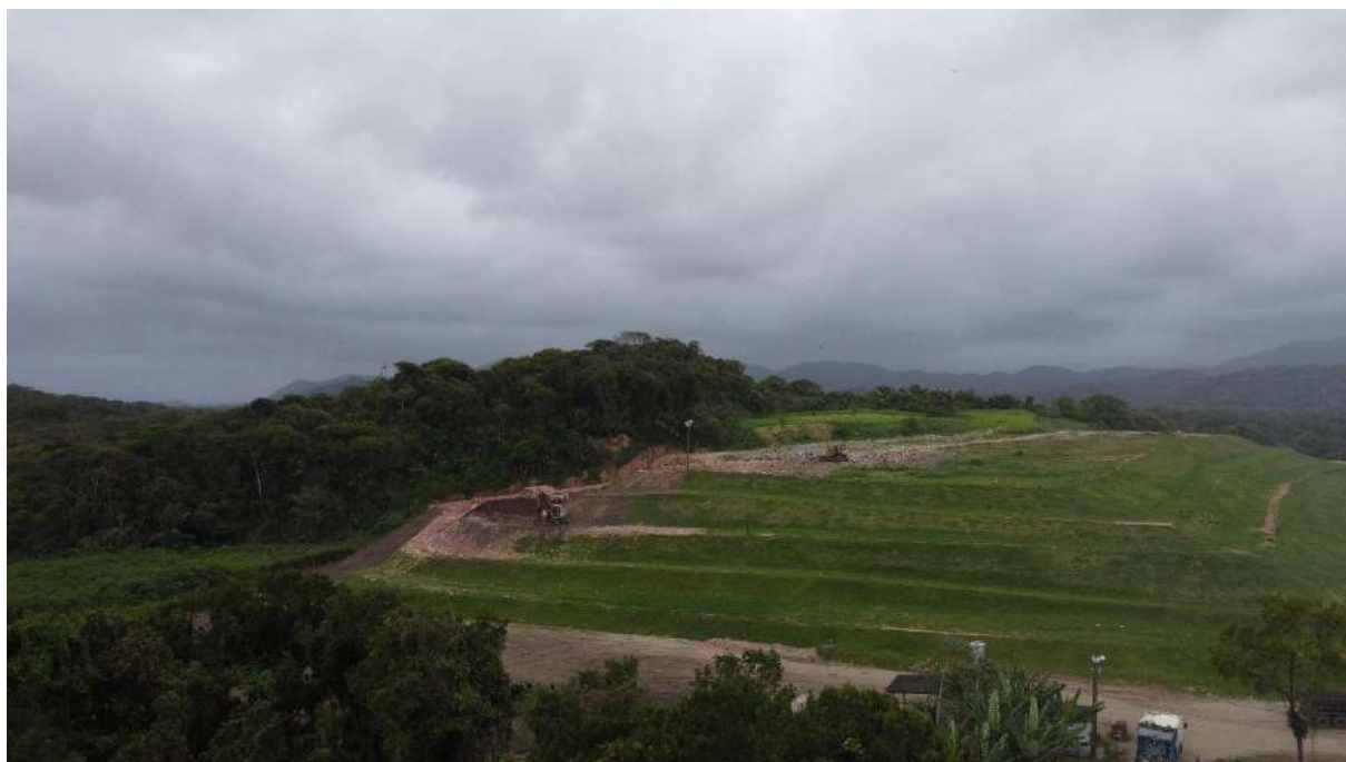
Aterro Sanitário Peruíbe
