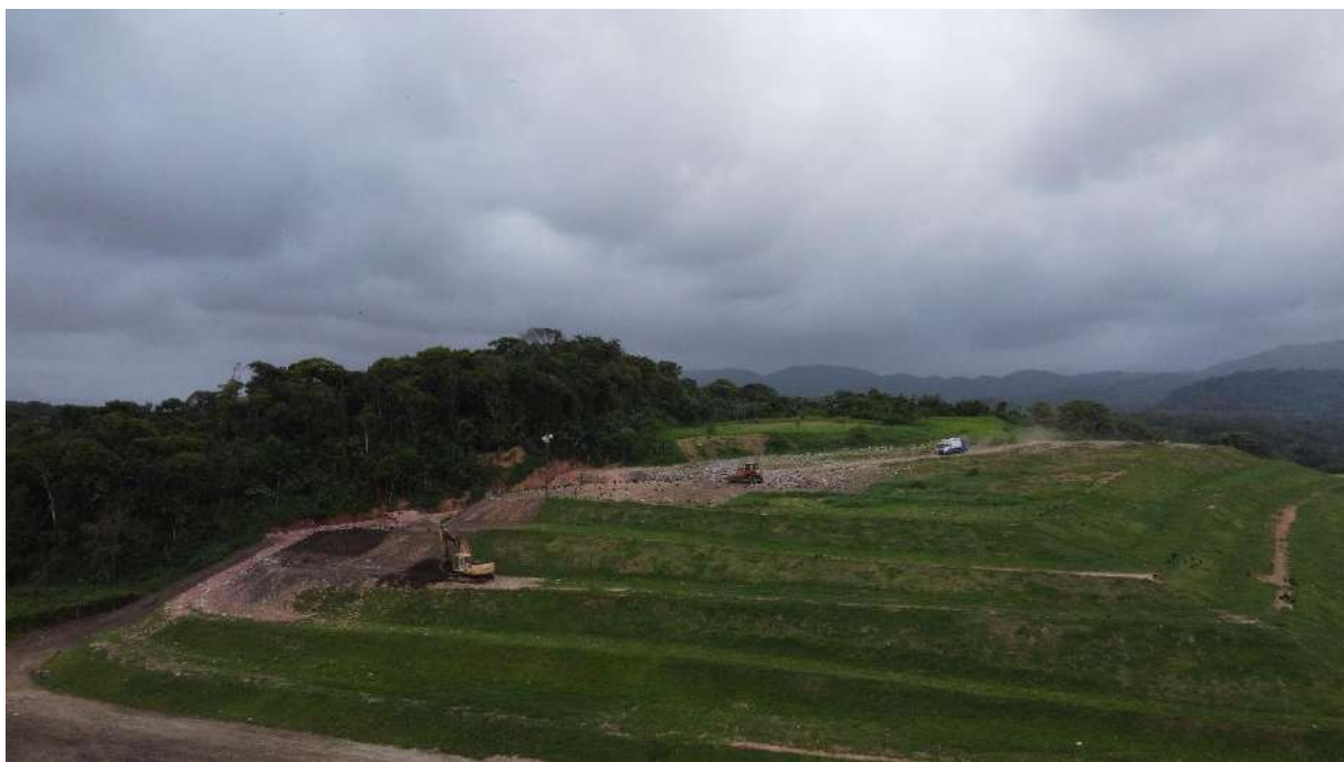
Aterro Sanitário Peruíbe
