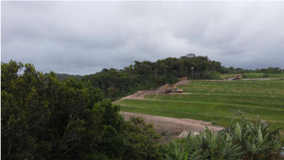
Aterro Sanitário Peruíbe
