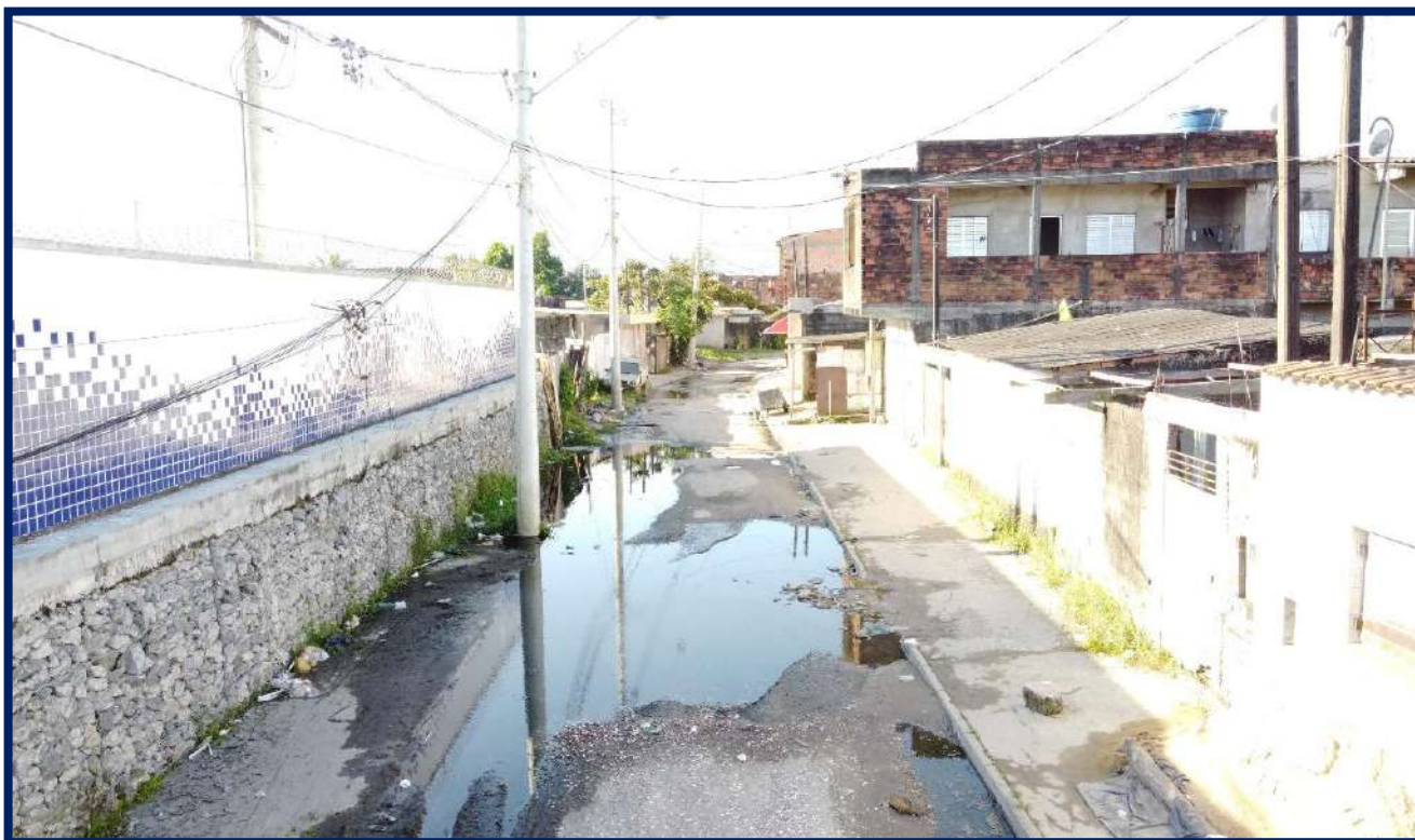
Esgoto a céu aberto ao lado da SABESP
