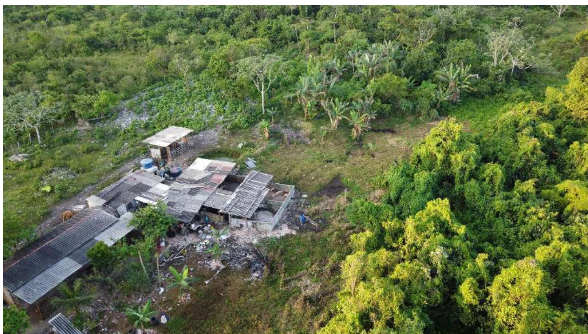
Área do antigo lixão aterrado e casas construídas na localidade
