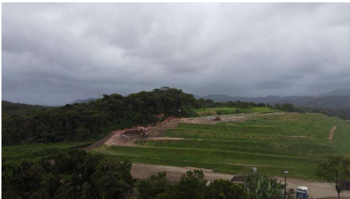
Aterro Sanitário Peruíbe
