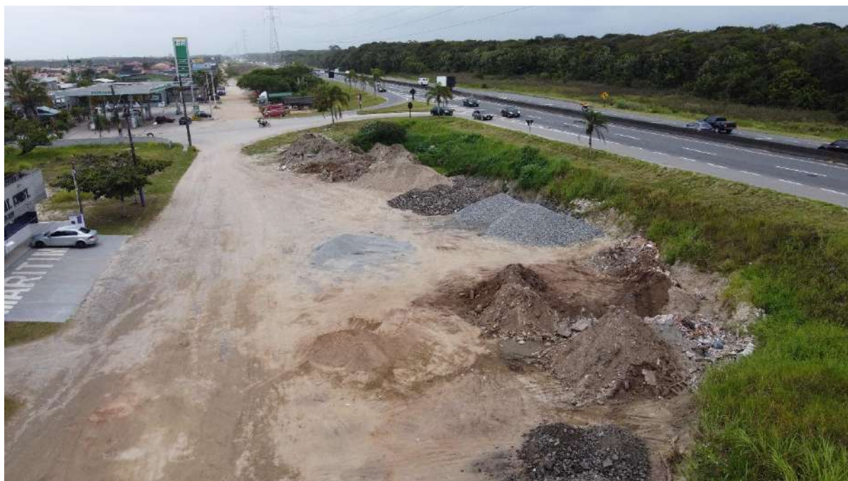
Disposição de materiais a céu aberto - Itanhaém
