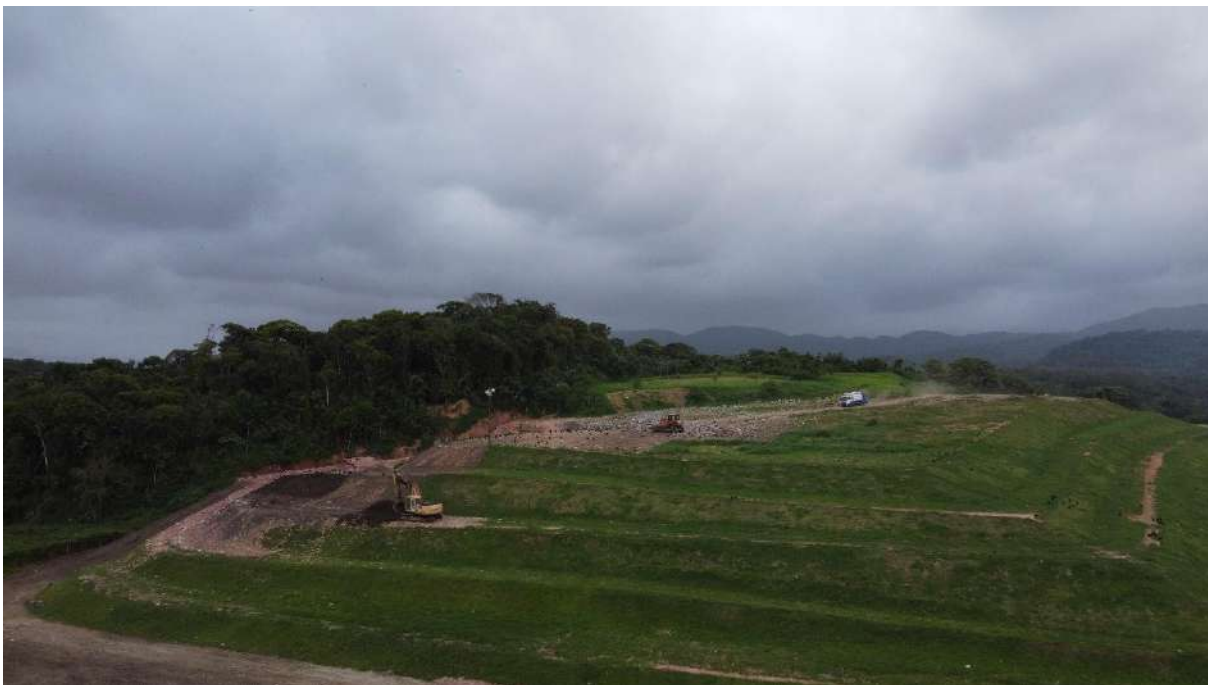
Aterro Sanitário Peruíbe
