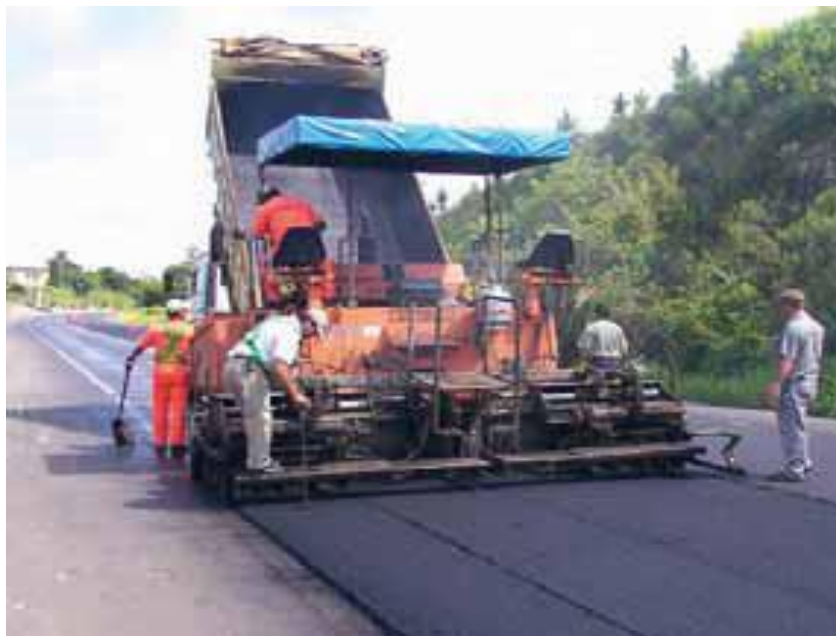
Figura 2.2 –Aplicação do Asfalto Ecológico (REVISTA PNEUS & CIA n° 09)
