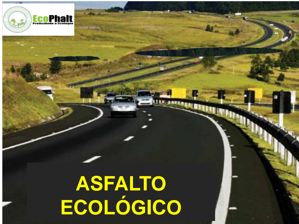
Figura 6.1 – Pavimentação com Asfalto Ecológico (PNEUS E& CIA)
