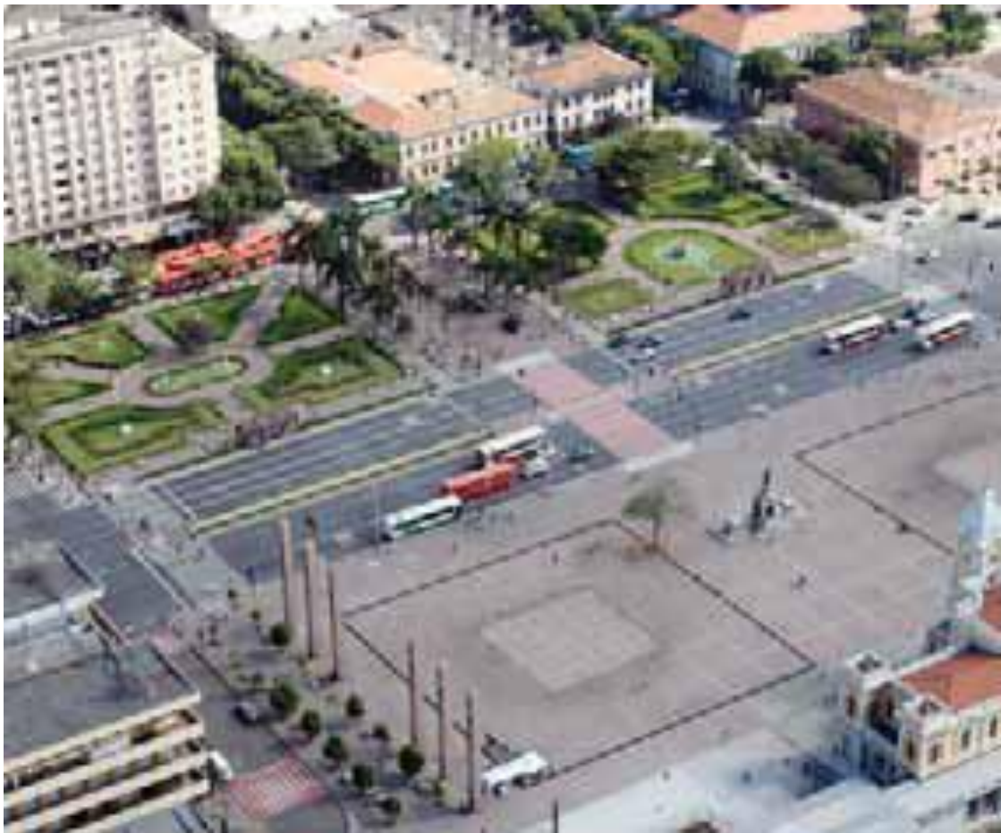
Figura 6.2 – Aplicação do asfalto ecológico no Boulevard Arrudas /MG. (PNEUS & CIA n° 09)
