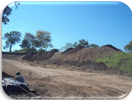
ZODME (Zonas de Depósitos de Materiales de Excavación Sobrante)
