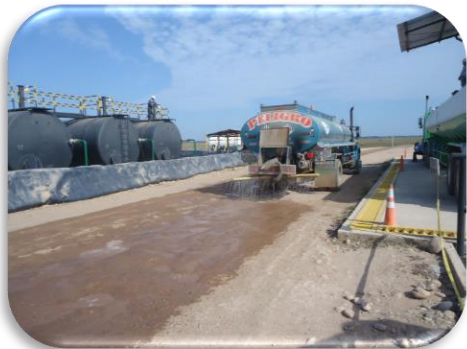
Riego en vías
