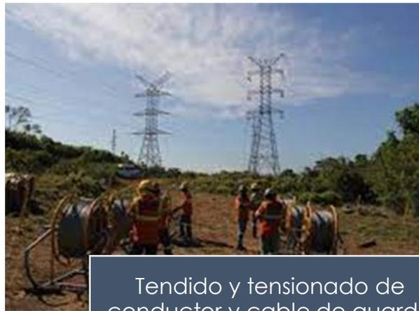
Tendido y tensionado de conductor y cable de guarda
