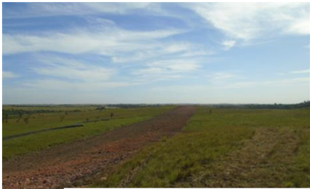
Conformación del derecho de vía (desmonte y descapote)
