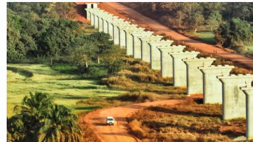
Rail de plus de 600km à travers de l'Haute- et Moyenne-Guinée
