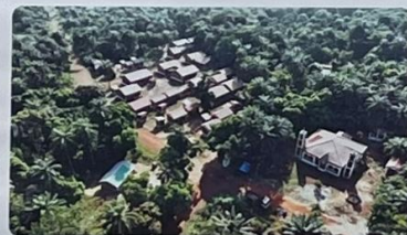
Vue aérienne du nouveau village de réinstallation
