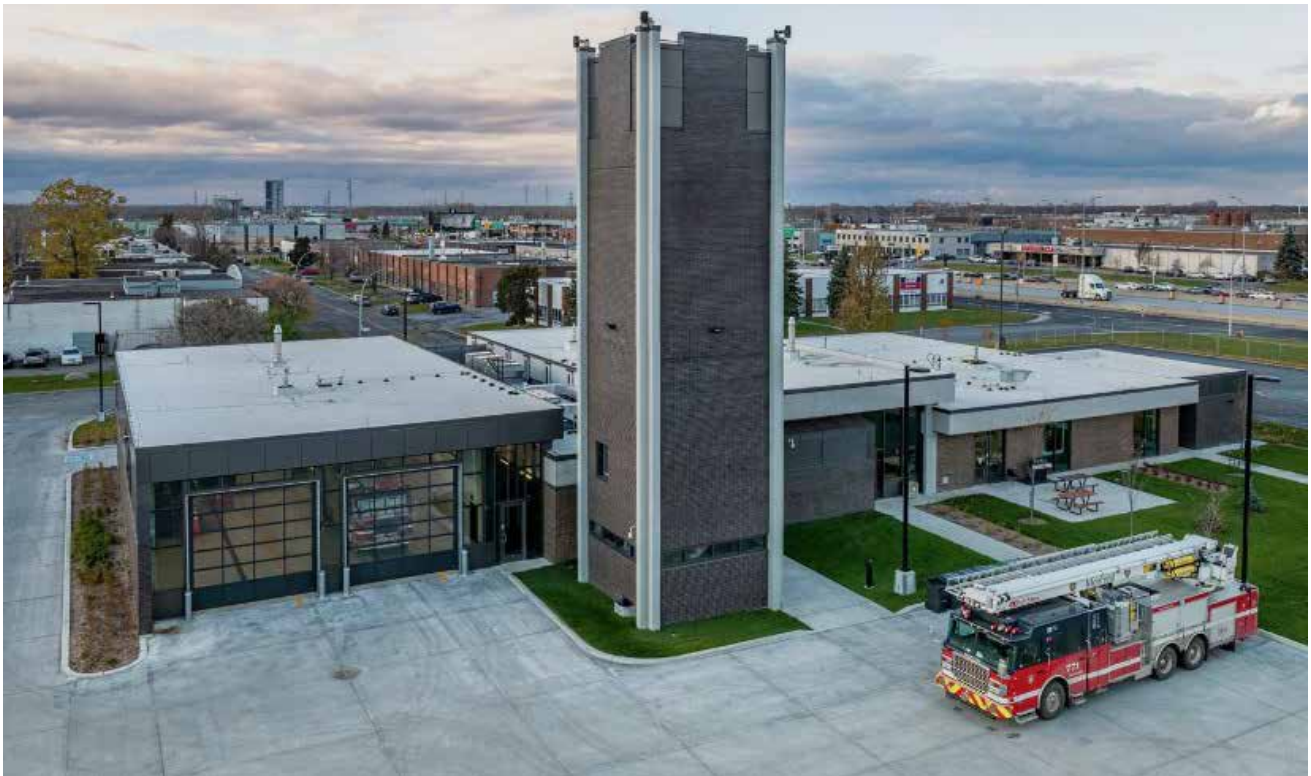
La caserne 2 de Ville Saint-Laurent, devenue aujourd'hui la caserne 71 du SIM et le Centre de formation de l'Ouest.
