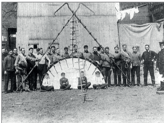
Sur cette photo, 4 échelles « ESCALADE » en premier plan avec un groupe de recrues en formation à la caserne 4 du Service incendie de Montréal. In this photo, 4 "ESCALADE" ladders in the foreground with a group of recruits in training at fire station 4 of the Montreal Fire Department.
