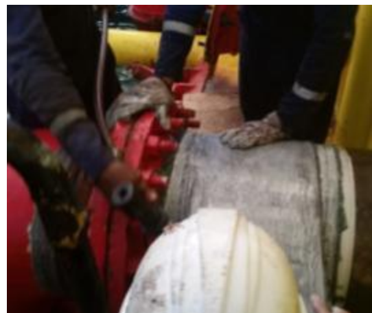
Foto No. 14 Envoltura de la fibra de Carbono TitanWrap
