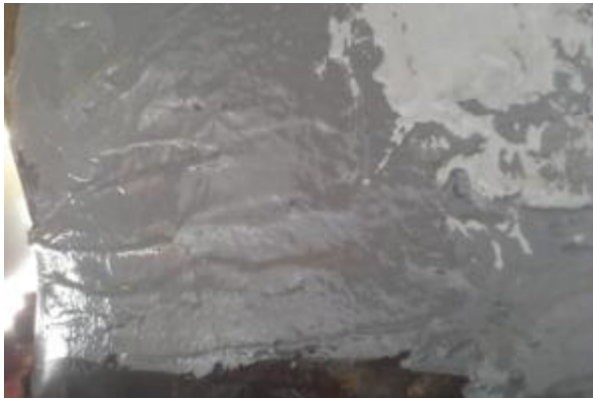
Foto No. 7 Aplicación de la masilla de relleno al área con pérdida de espesor por corrosión.
