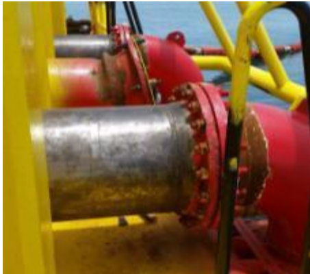
Foto No. 5 Preparación de superficie obtenida.
