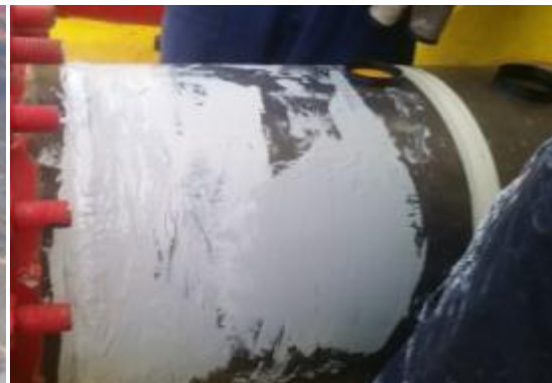
Foto No. 12 Se realizó el relleno de los defectos 1, 2 y 3. Adicionalmente se rellenaron las áreas con pequeñas pérdidas de espesor encontradas en la zona a reparar.
