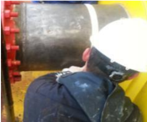
Foto No. 9 Preparación de superficie recibida
