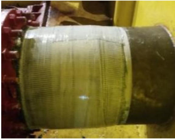
Foto No. 15 Fibra de Carbón TitanWrap instalado
