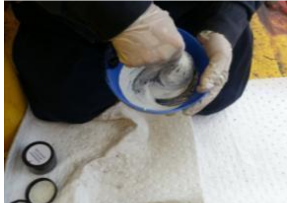
Foto No. 6 Mezcla del epoxico de relleno
