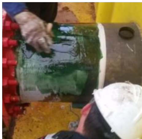
Foto No. 13 Aplicación del Imprimante
