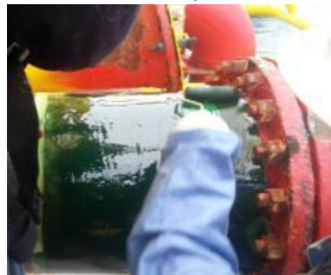
Foto No. 8 Aplicación de epoxico imprimante alrededor de todo el perímetro.
