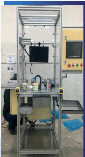
Estación de suministro de orings y acople de conector y revisión con SV. DENSO
