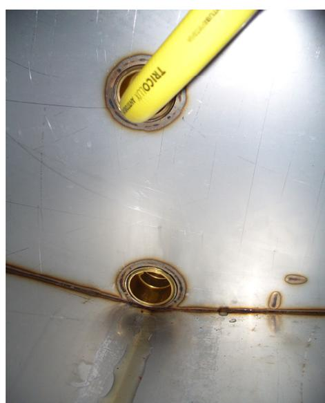
**Verificare che sia funzionante e non otturato, infilare la gomma all'interno e fare scorrere l'acqua a pressione.**
