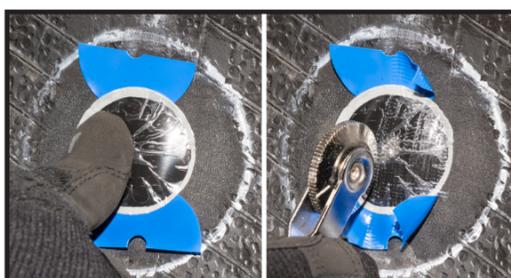
**9.** Con el pulgar presione la reparación hacia abajo desde el centro hacia afuera. Con el rodillo presione hacia abajo la unidad de reparación desde el centro hacia afuera. Quite el película azul de poli azul de abajo de la tapa y continúe presionando con el rodillo hacia el borde de la reparación.
