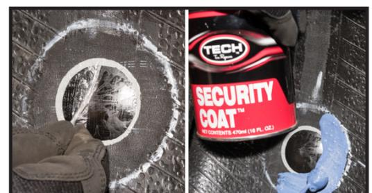
**10.** Quite el poli transparente de la reparación. Con Security Coat de Tech (#738) selle el borde de la reparación y el área raspada excedente.
