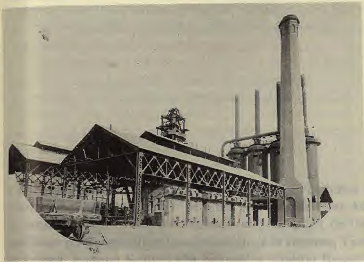
Compañía Fundidora de Fierro y Acero de Monterrey, La Maestranza (1900) Fototeca AGENL
