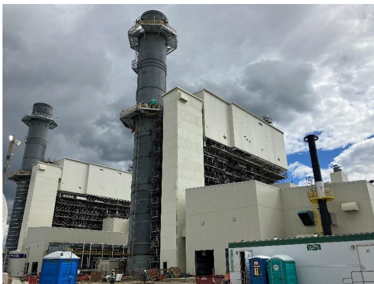
Figure 15 - HRSG Penthouse Installation at Cascade
